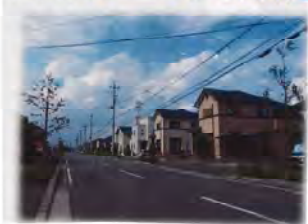
施行完了エリアの状況
